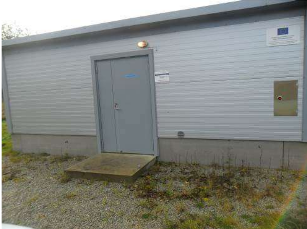
Martna puurkaev-pumpla ja veetöötlushoone
