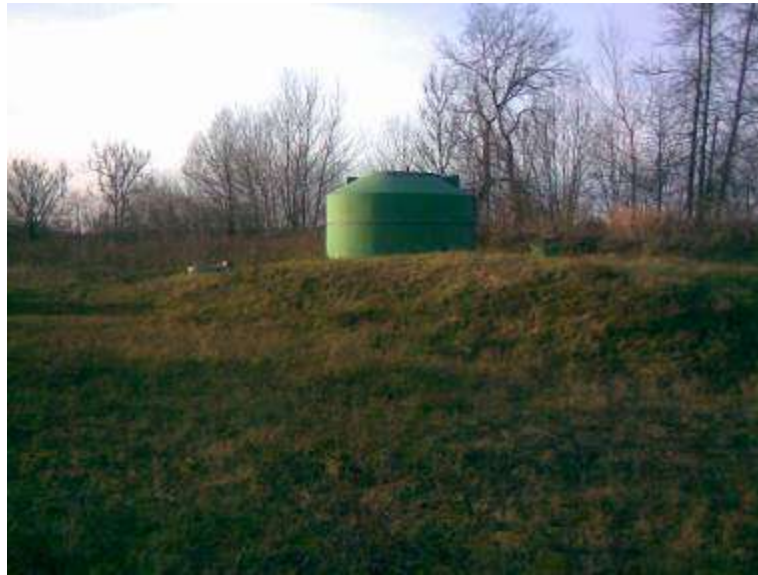
Rõude reoveepuhasti RVPJ
